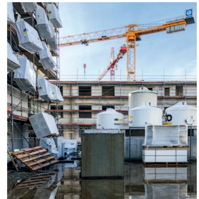
Materialplanung „lean“: Das Material für das Wärmedämmverbundsystem hat sich der Nachunternehmer genau „vorphortioniert“ liefern lassen – so nah wie nur irgendmöglich an den Einsatzort.
