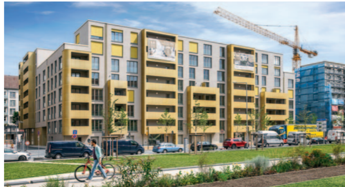
Wallstraße II.1, Dresden: 117 schlüsselfertige Wohnungen. Der Innenausbau im Lean-Verfahren wurde pünktlich abgeschlossen – mit nur 11 Abnahmemängeln.
