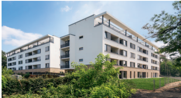
Lincoln Siedlung, Darmstadt: Weit vor der Übergabe an den Bauherrn erfolgten alle nötigen Vorbegehungen und Abnahmen.
