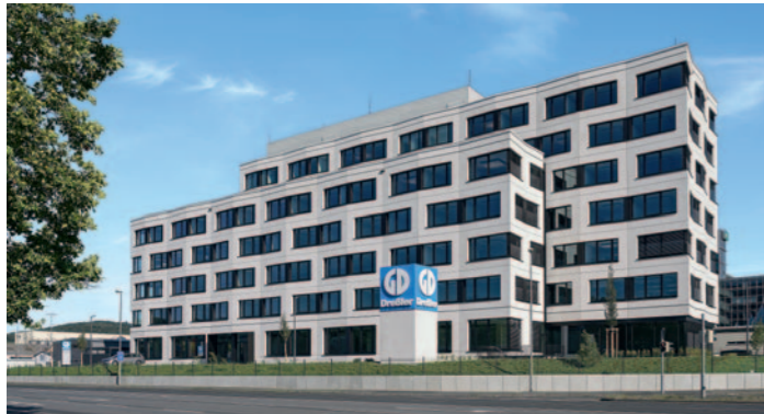
Dreßler Haus, Aschaffenburg: Unsere neue Unternehmenszentrale. Trotz Pandemieeinbruch wurde die Gesamtbauteilzeit von nur 17 Monaten eingehalten.
