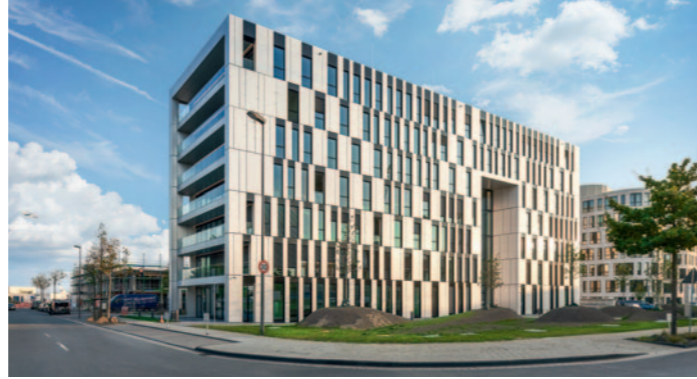
Bürohaus Shift, Düsseldorf: Unvorhergesehene Funde im Erdreich mussten aufwendig entsorgt werden. Dank Taktung wurde dennoch der Zeitrahmen eingehalten.
