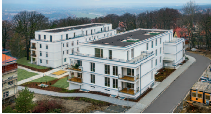
Malerstraße, Dresden: 4 Gebäude mit je 38 Wohnungen. Dank Taktsteuerung mit dem Gewerk Innenputz wurden 3 Wochen Kältestopp wieder aufgeholt.
