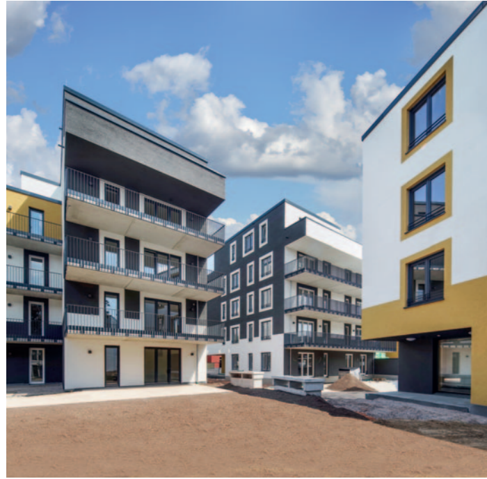
Kinzhöhfe, Kehl: Aufgrund der räumlichen und zeitlichen Enge wurde bereits weit vor Projektstart entschieden, das Bauvorhaben nach Lean Construction zu takten. Erst nachdem der Bauablaufplan mit dem Bauherrn abgestimmt war, wurde der Rohbau begonnen.
