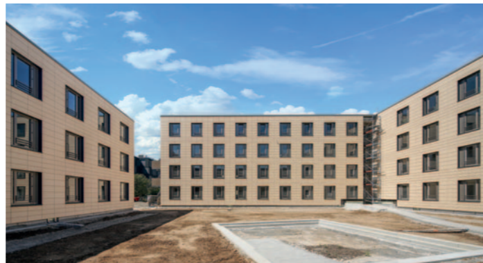
BIZ, Mannheim: In 330 Tagen 506 Zimmer mit Bad. Das Projekt verdankt seinen Erfolg nicht zuletzt der strikten Einhaltung der täglichen Lean-Besprechung.
