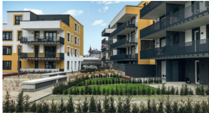
Kinzighöfe, Kehl: Der Bauablaufplan erlaubte – trotz engem Baufeld – die Berücksichtigung zahlreicher Eigentümerwünsche.
