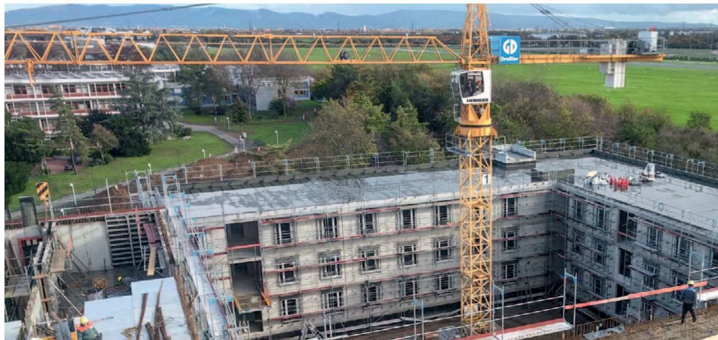
Durch spezielle Einbringöffnungen wurden die eigens entwickelten Nasszellen noch im Rohbau als fertige Module eingesetzt.
