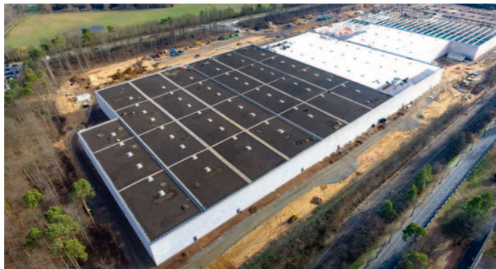
Logistikzentrum ICO, Obernburg: 27 pro Tag – auch Stützpfeiler lassen sich gut takten. Daher wurde unser bis dahin größter Hallenauftrag frühzeitig fertig.
