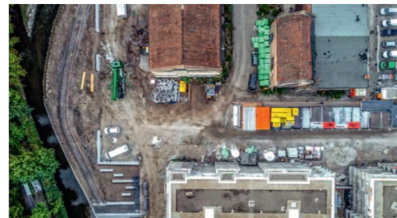
So aufgeräumt sieht eine „Lean-Baustelle“ aus. Jedes Nachunternehmen hat sein ihm zugewiesenes Materialdepot – und wird auch hinsichtlich Ordnung und Sauberkeit bewertet.
